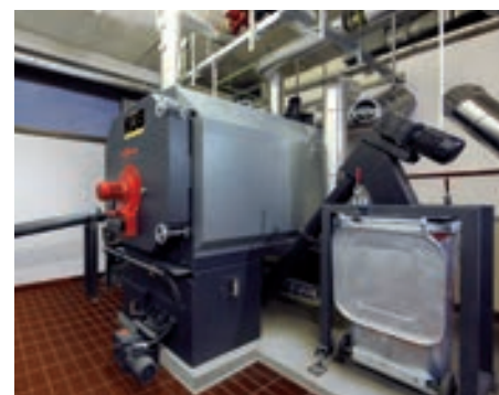
Академия бизнеса, Lustenau Котел Pyrot мощностью 220 кВт
