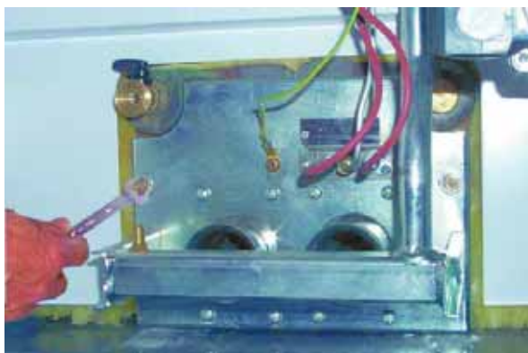
рис. 23 - Демонтаж горелок
