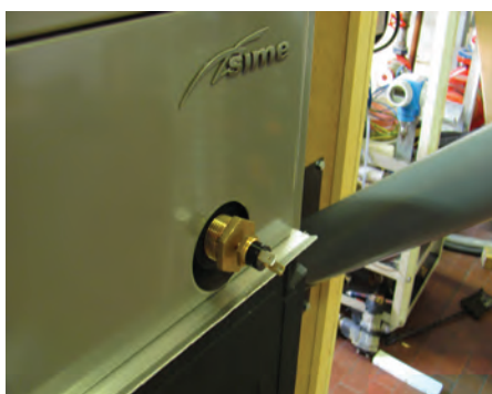
Рис. 9 Предохранительный термостат
