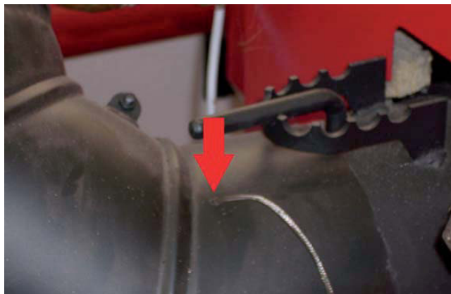
Установка датчика температуры дымовых газов
