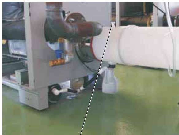
Измерительное отверстие на конденсатоотводчике
