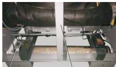
Система подъема конденсата Соединение бустерного насоса и насоса конденсата (соединения выполняются на жгуте проводов за стойкой)
