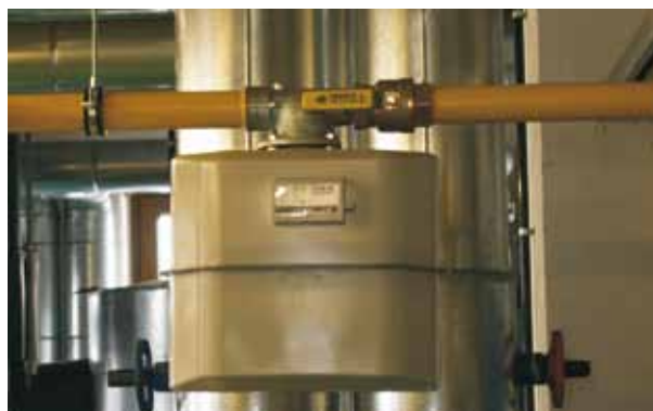
Подвод газа: опасность отравления и взрыва из-за утечки газа
