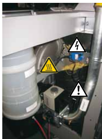
Запальный трансформатор, высоковольтный запальный электрод, комбинированный газовый клапан, реле давления газа, вентилятор, камера сгорания Опасность поражения электрическим током, опасность отравления и взрыва из-за утечки газа, опасность ожогов из-за горячих деталей.
