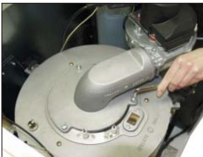
Вытащить уплотнение горелки и горелку, почистить горелку с помощью пылесоса и промыть водой.
