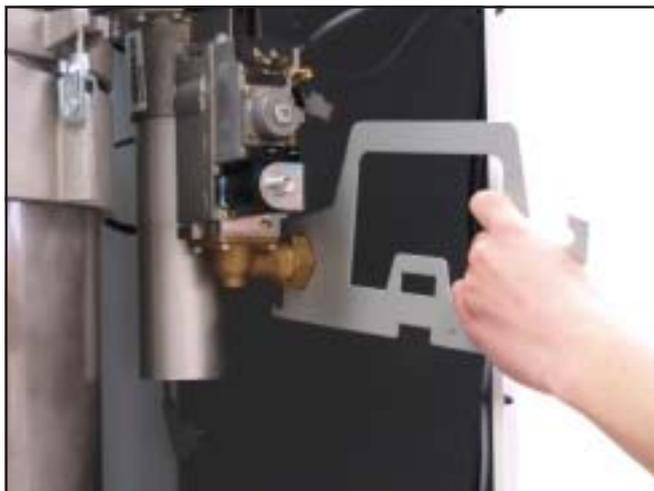
С помощью внутреннего шестигранника открутить винты 6 мм (3x) на крышке теплообменника. Вытащить вентилятор с отводом.
