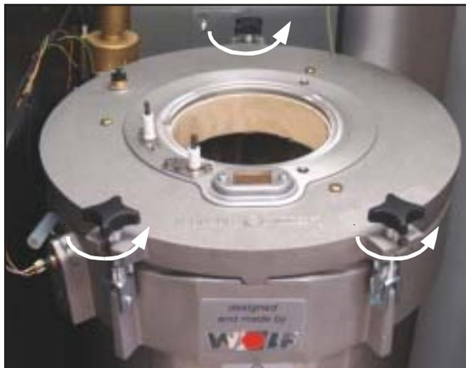
Приподнять крышку теплообменника с помощью специального инструмента (входит в комплект поставки).
