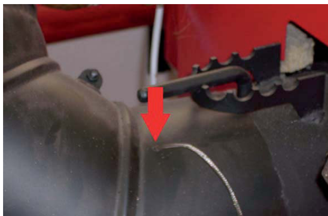
Установка датчика температуры дымовых газов
