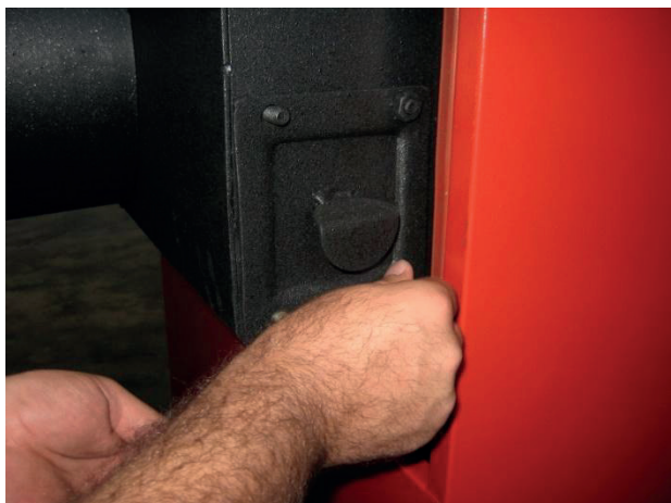
Рис. 9. Снятие заглушки для чистки адаптера дыма .
