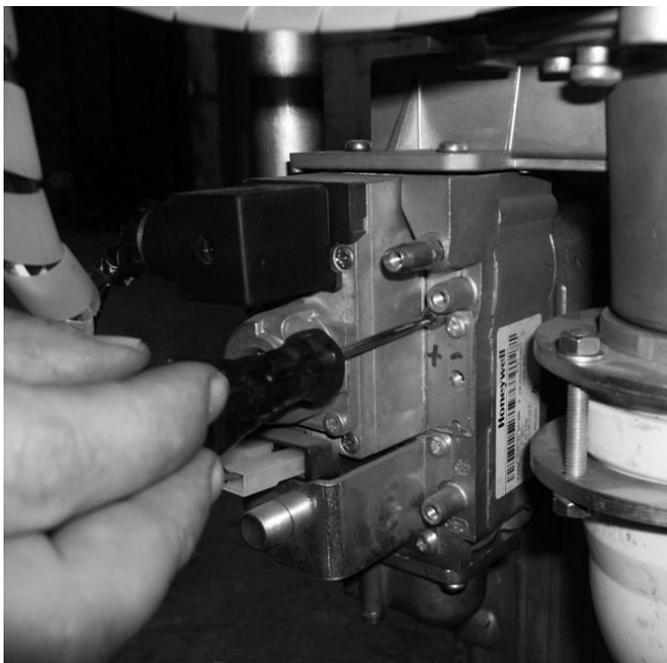
Выполните указанные выше операции с помощью подходящего инструмента (для установки максимальной подачи газа используйте отвертку).
