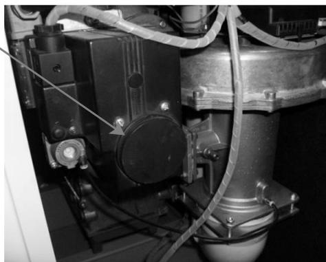
Регулировка (увеличение или уменьшение) подачи газа производится по данным анализатора дымовых газов, измеряющего содержание  $O_2$ ,  $CO_2$  и CO. Вращайте шток клапана ключом-шестигранником подходящего размера вправо или влево для уменьшения или увеличения подачи газа, соответственно. Регулировка считается выполненной после достижения необходимых показателей, приведенных таблице.
