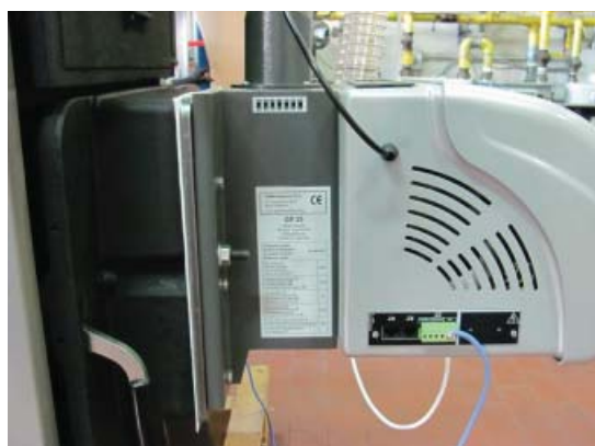
Рис. 26 Крепеж горелки
