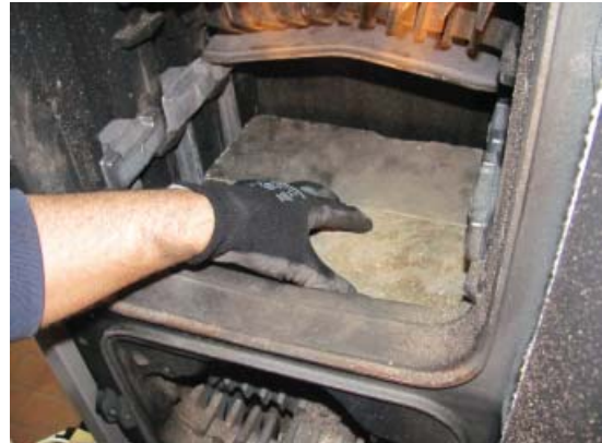
Εικ. 20 Τσιμεντένιες πλάκες
