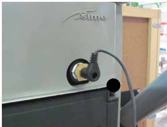
Εικ. 34 Συνδετήρας θερμοστάτη ασφαλείας
