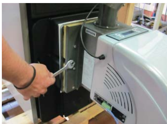
Рис. 25 Монтаж горелки
