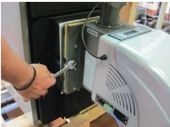
Εικ. 25 Τοποθέτηση καυστήρα
